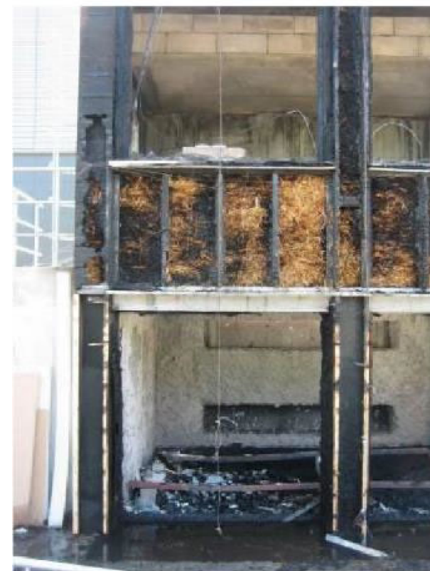
Vue de l'allège SUD après refroidissement
