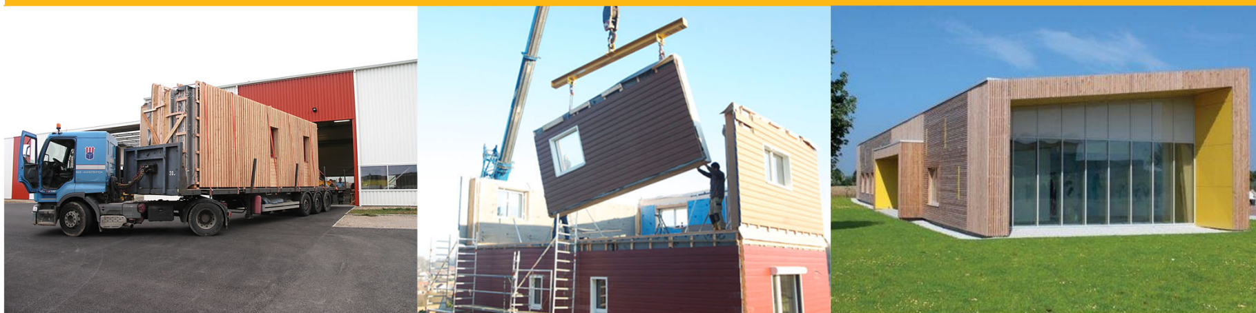
La construction de bâtiments en ossature bois et isolation paille
