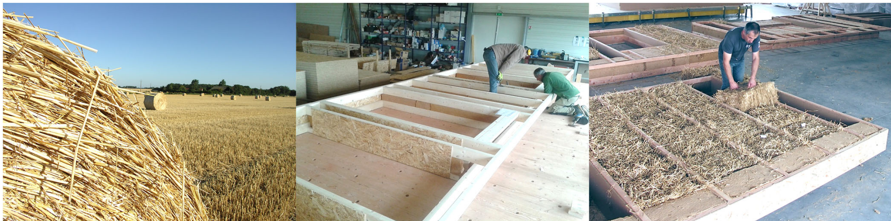
La construction de bâtiments en ossature bois et isolation paille
